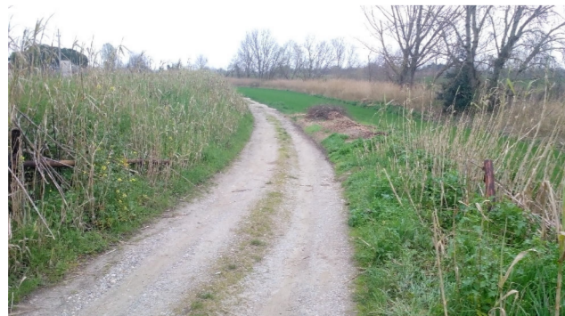
foto 8 sbarra esistente da ripristinare
